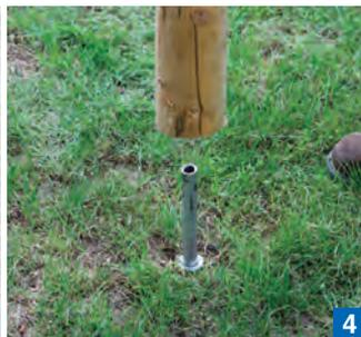
Colocación del poste madera sobre el anclaje.
