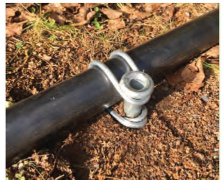
Tubo fijado con clip y anclaje.
