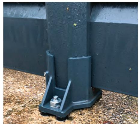
Fijación de una pletina sobre hormigón.
