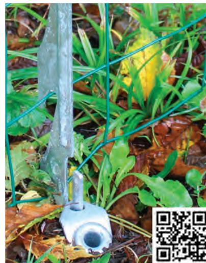
Clip malla colocado. Escanear para visionar el video.
