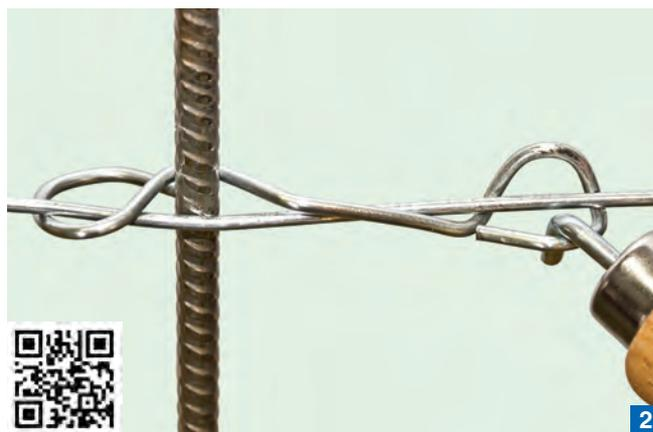
Colocar la herramienta dentro del bucle del clip y pasar por debajo del alambre. Escanear para visionar el video.
