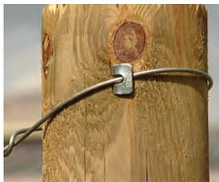
Grampillon instalado y replegado. Escanear para visionar el video.
