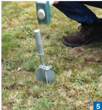
5 Clavar el anclaje con el util.
