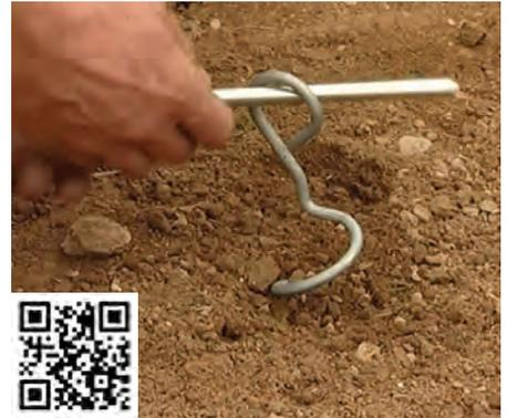
Colocación del anclaje tirabuzón. Escanear para visionar el video.
