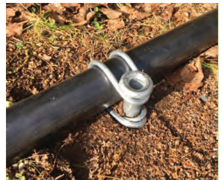
Tubo fijado con clip y anclaje.
