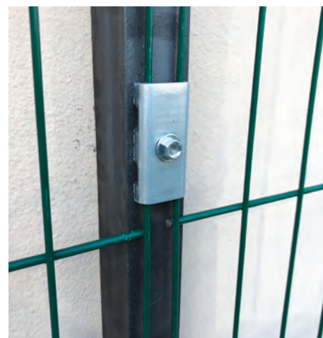
Malla rígida sostenida con pletinas tipo 1.
